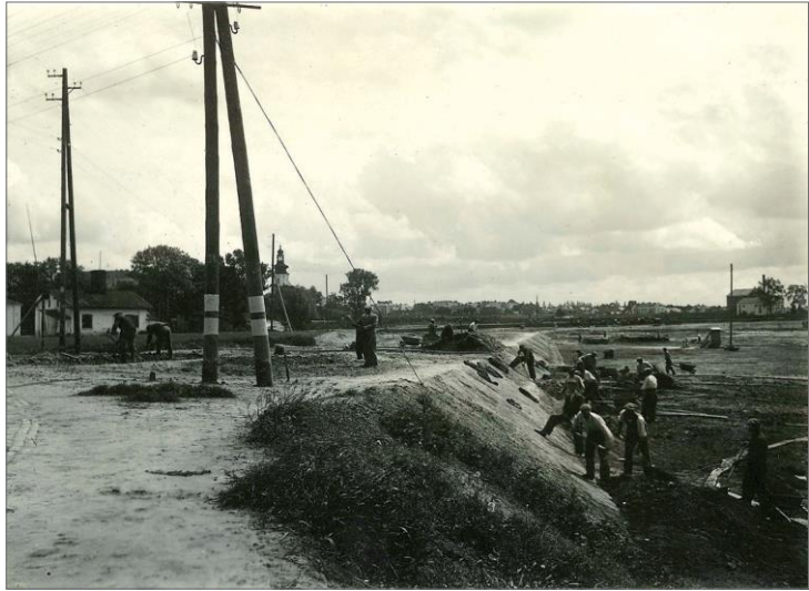
Ryc. 1. Budowa drogi do projektowanej Fabryki Polskiego Monopoli Tytoniowego – dzisiejszej ul. Męczenników Rotundy (skrzyżowanie z ul. Szczepreską), autor Tadeusz Zaremba. Archiwum Państwowe w Zamościu, Akta miasta Zamościa 1915-1939, sygn. 565, s. 64 (88.1178.0.9.259)
