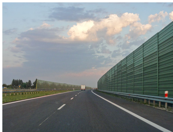
Fot. 2. Droga ekspresowa S17. Fot. S. Bernat
