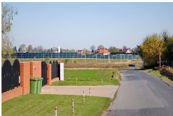
Fot. 3. Ekrany akustyczne obniżają walory krajobrazowe oraz podzieliły wieś Kolonia Dąbrowica. Fot. J. Trojanowska, 2014
