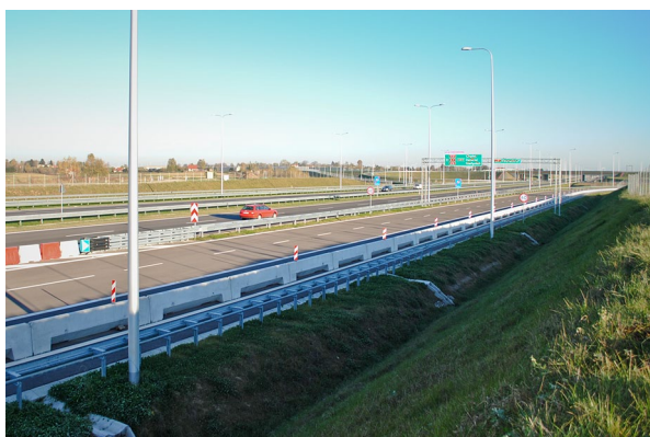
Fot. 1. Droga ekspresowa S12/17 na wysokości wsi Barak. Fot. J. Trojanowska, 2014
