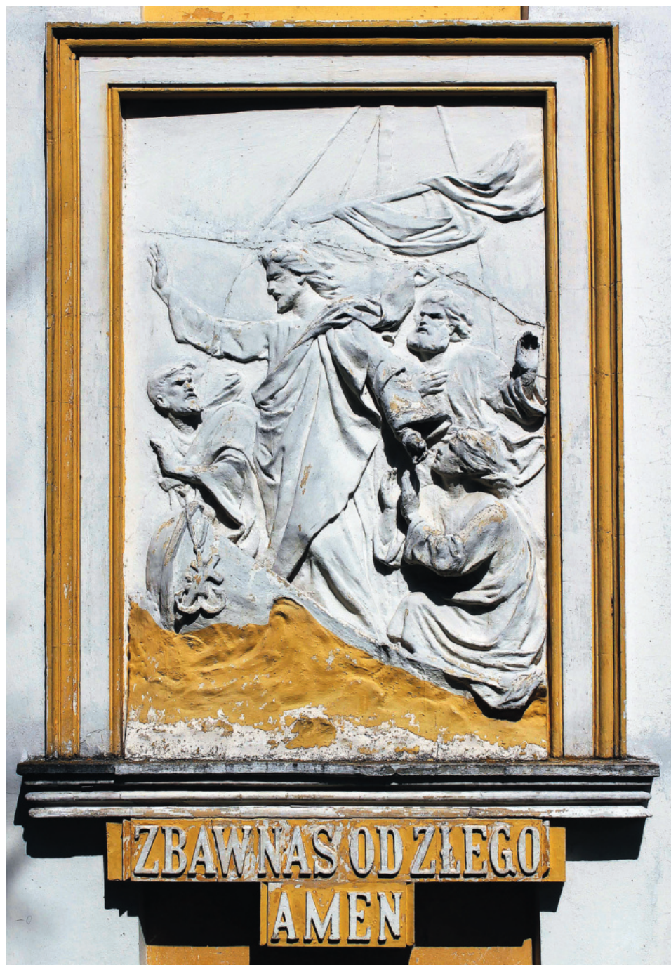
Il. 4. Guzów, absyda kaplicy pw. św. Feliksa de Valois.
