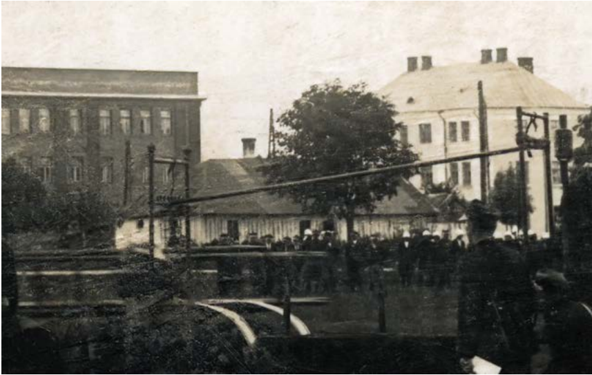
Il. 13. Dom dróżnika kolejowego w obrębie ładowni Nowa Osada mieszczący się w przebudowanej szopie z okresu I wojny światowej. W tle zabudowania ul. Nowej (G. Orlicz-Dreszera) i ul. Lwowskiej (Partyzantów), autor N.N., ok. 1930 roku.
