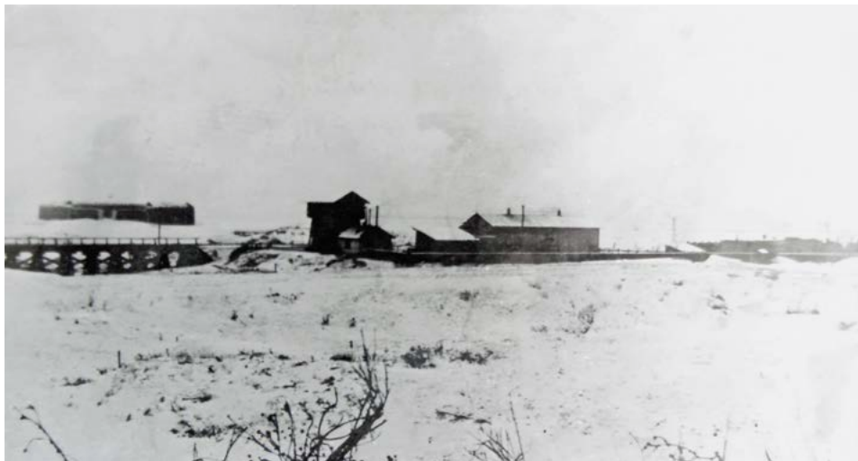
Il. 5. Zaplecze techniczne stacji Zamość: wieża ciśnień, przepompownia, szopa oraz parowozownia. Po prawej widoczny drewniany most przez Łabuńkę, w głębi – składnica prochu (Rotunda), autor N.N., około 1925 rok.
