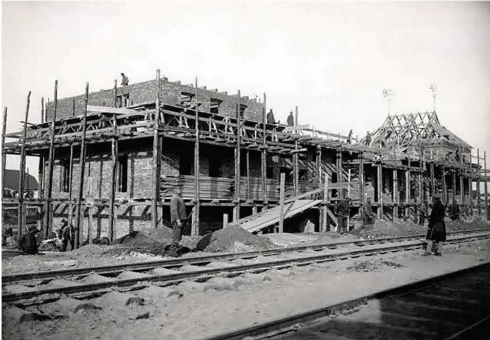
Il. 2. Budowa dworca kolejowego na stacji Zamość, autor N.N., wiosna 1916 roku.
