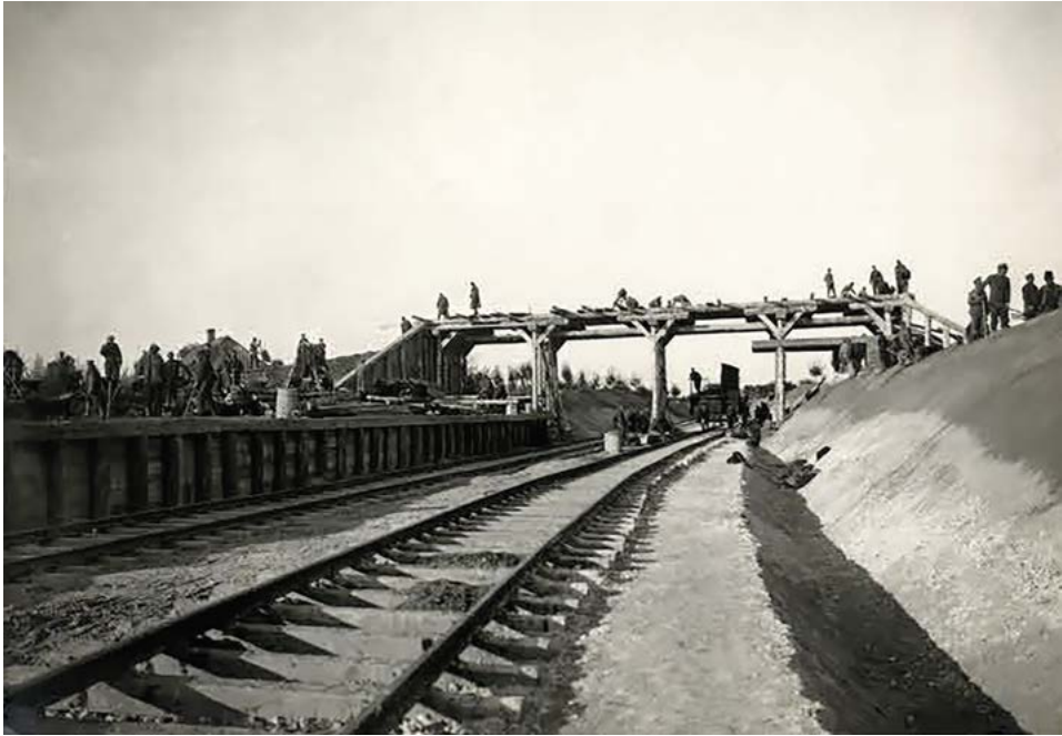
Il. 12. Budowa drewnianego wiaduktu w obrębie ładowni Nowa Osada w trakcie realizacji linii kolejowej Zamość – Włodzimierz, autor N.N., kwiecień 1917 roku.
