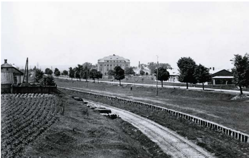
Il. 14. Ładownia Nowa Osada w Zamościu od strony północnej, po rozbiórce wiaduktu. Po prawej rampa, z lewej gospodarstwo kolejowe, w głębi gmach Banku Polskiego przy ul. Lwowskiej, autor N.N., około 1930 rok.
